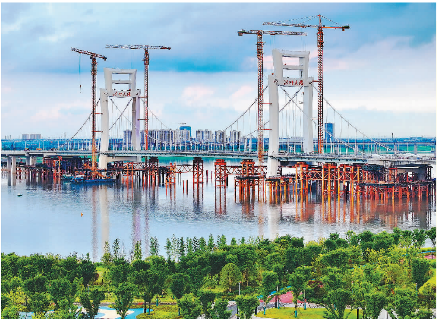
洪州大桥横跨赣江，是一条连接江西南昌市红谷滩区九龙湖片区和南昌县小蓝经开区的城市快速路、城市特大桥，大桥主桥为双向8车道，设计时速80公里，预计年内通车，建成后将成为南昌南部重要客货运交通快速通道，为群众出行、货物运输营造更加便捷畅达的交通环境。图为大桥建设现场。 朱海鹏摄(人民视觉)
