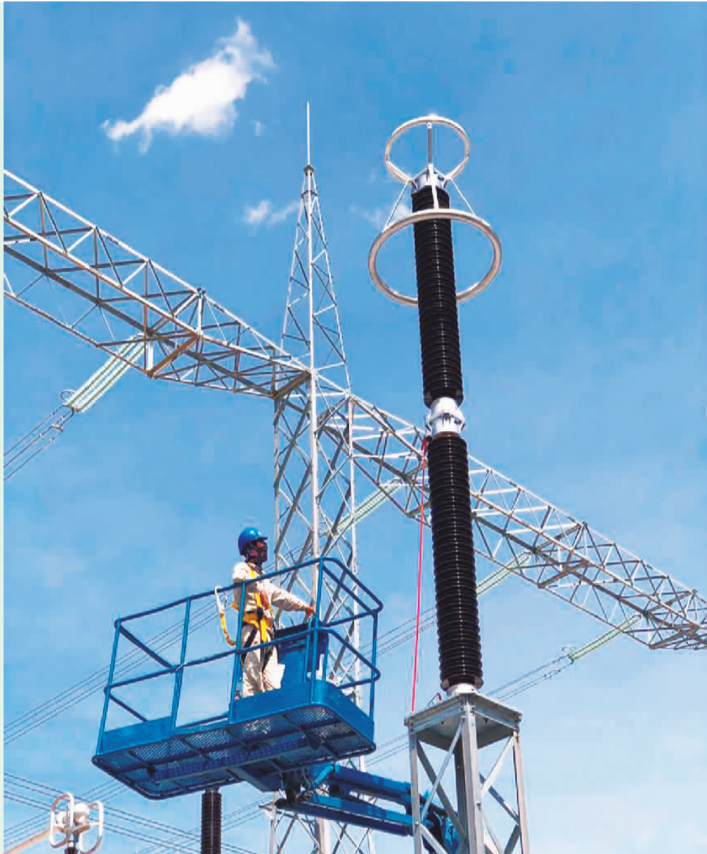
美丽山二期项目换流站设备安装现场。
