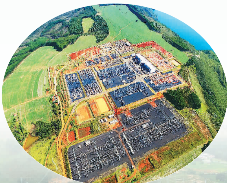
▲美丽山一期项目伊斯特雷都换流站。
