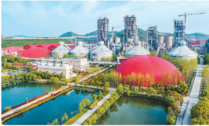
安徽海螺集团持续加快绿色低碳新技术、新工艺、新材料、新装备的研发应用,打造资源节约型、环境友好型现代化绿色工厂。图为芜湖海螺水泥有限公司超大型水泥熟料生产基地。 肖本祥摄(人民视觉)
