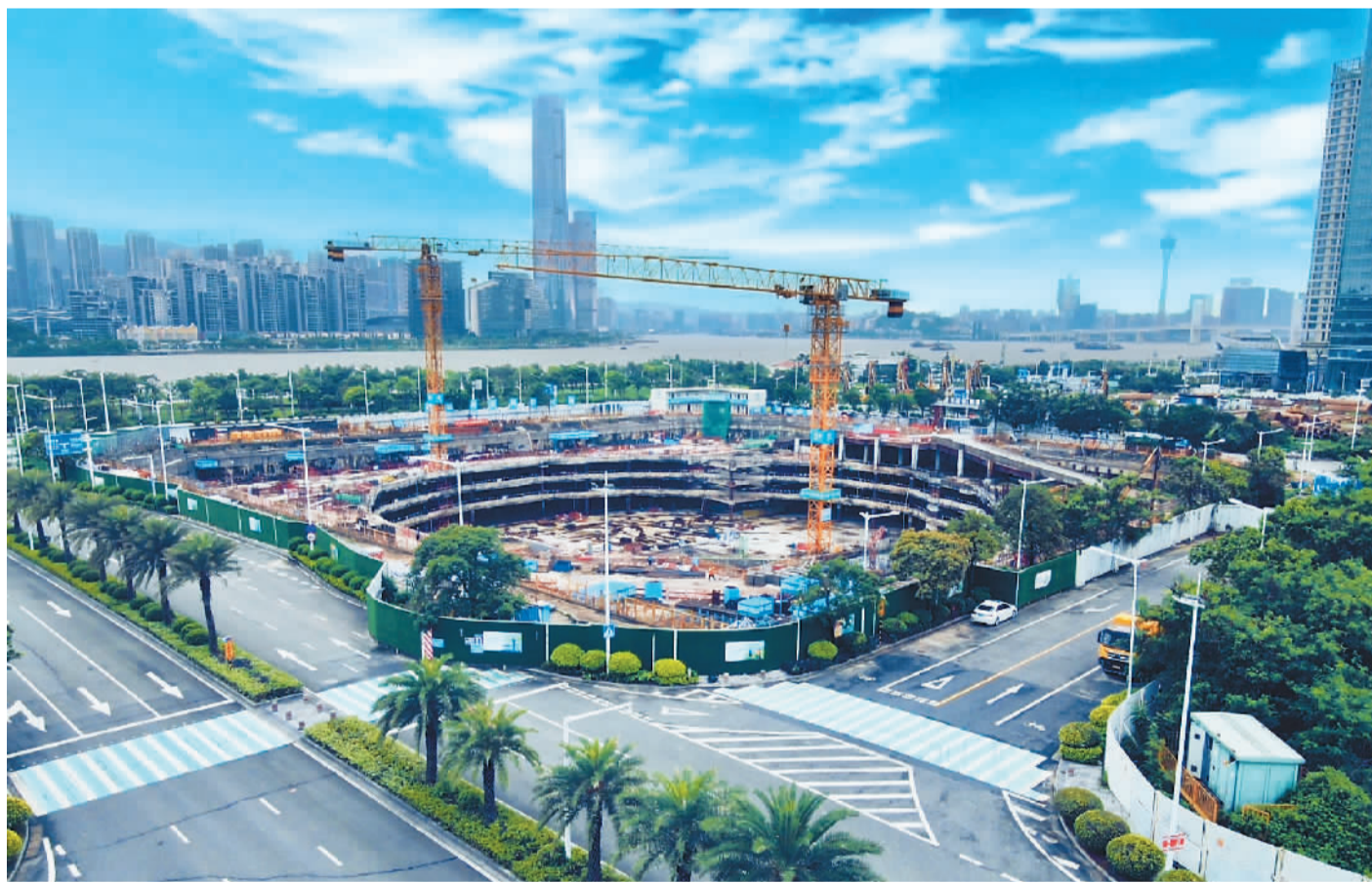
近日，珠海IDG中心项目地下室首块底板浇筑完成。该项目位于广东省珠海市横琴金融岛，矗立于十字门水道旁，远眺澳门，由中建四局承建，为集办公、住宅、商业一体的多功能综合性建筑群，总建筑面积22.76万平方米，建筑高度208米，建成后积极对接粤港澳大湾区人才生活就业需求，服务粤港澳大湾区发展。图为项目建设现场。傅银摄（人民视觉）
