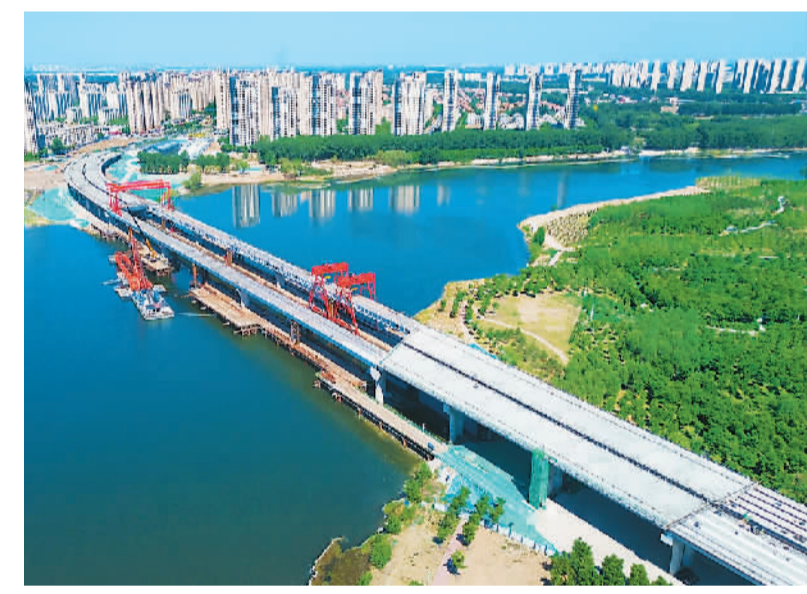
厂通路潮白河大桥项目主桥施工紧张进行中。 王恒摄(人民视觉)
