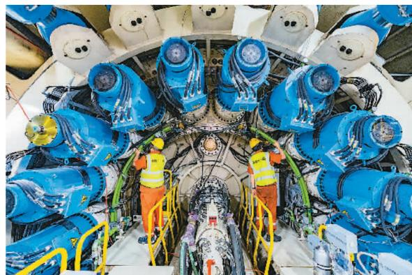
近日，由中铁十一局承建的深江铁路深莞隧道西段“鲲鹏号”盾构机顺利始发。深江铁路是中国“八纵八横”高铁网沿海通道的重要组成部分。该工程建成后，深圳与江门可实现1小时内通达，深圳与广州南沙可实现半小时高铁互联互通。图为施工人员在检查“鲲鹏号”盾构机刀头组件运行状况。
