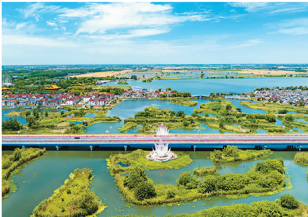
江苏省兴化市近年大力建设“四好农村路”，让连接着一座座村庄、一块块农田、一个个果园的农村公路托举起乡亲们的美好生活梦想，有效推进乡村全面振兴。图为兴化市农村公路夏日图景。周杜根摄(人民视觉)
