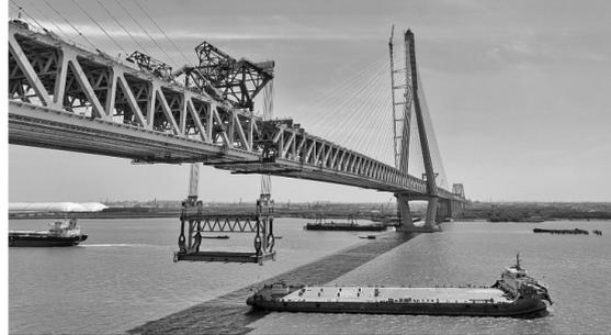
5月29日拍摄的常泰长江大桥主航道桥合龙段钢桁梁吊装现场(无人机照片)。当日，常泰长江大桥主航道桥最后一节钢桁梁——合龙段钢桁梁顺利吊装到位，拉开主桥合龙的序幕，预计6月上旬完成合龙，实现全桥贯通。
