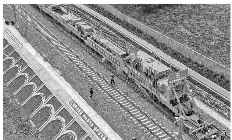
5月28日，中国在建最北端高铁——哈尔滨至伊春高铁正式进入铺轨施工阶段。图为铁力至伊春段铺轨施工现场。(哈铁供图)
