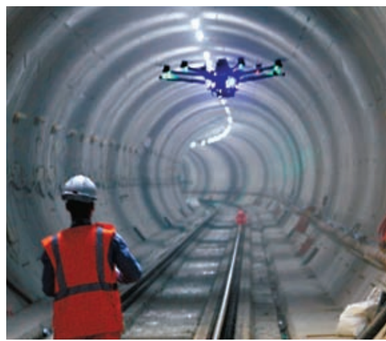
◆倫敦地鐵施工團隊使用無人機進行測量和監控。網上圖片
