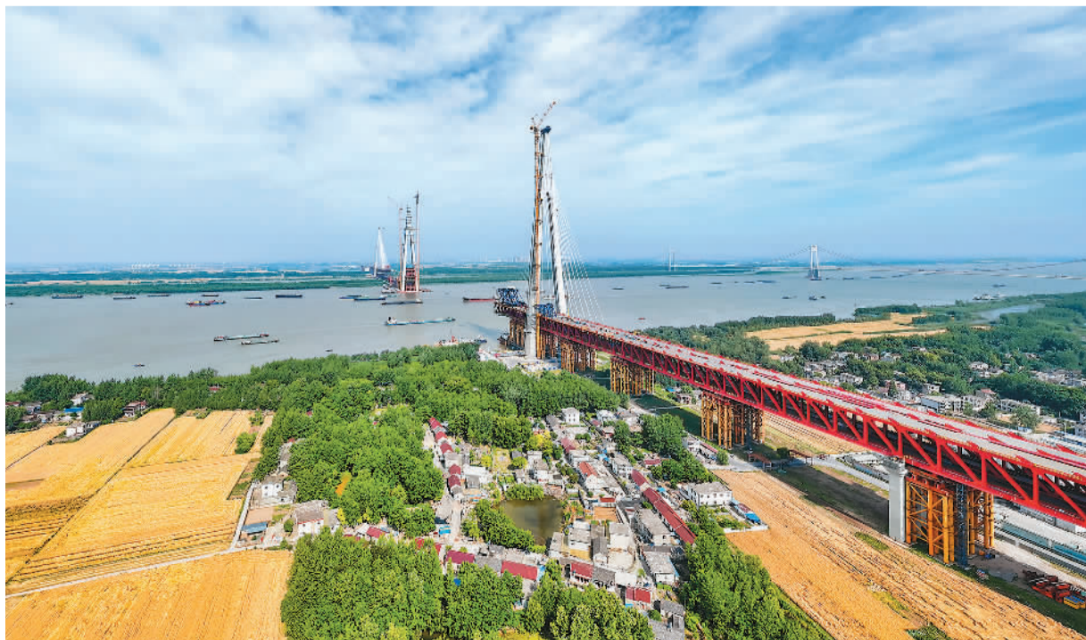
安徽省马鞍山市长江公铁大桥是巢马城际铁路控制性工程,主桥总长3248米,建成后将成为世界上首座双主跨超千米的三塔斜拉桥和世界最大跨度三塔斜拉桥,同时也是世界上最长联钢桁梁斜拉桥。巢马城际铁路建
