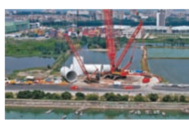
◆全球單機容量最大「海上風電機組」在廣東汕頭臨海試驗基地進行塔筒吊裝。 香港文匯報廣東傳真
