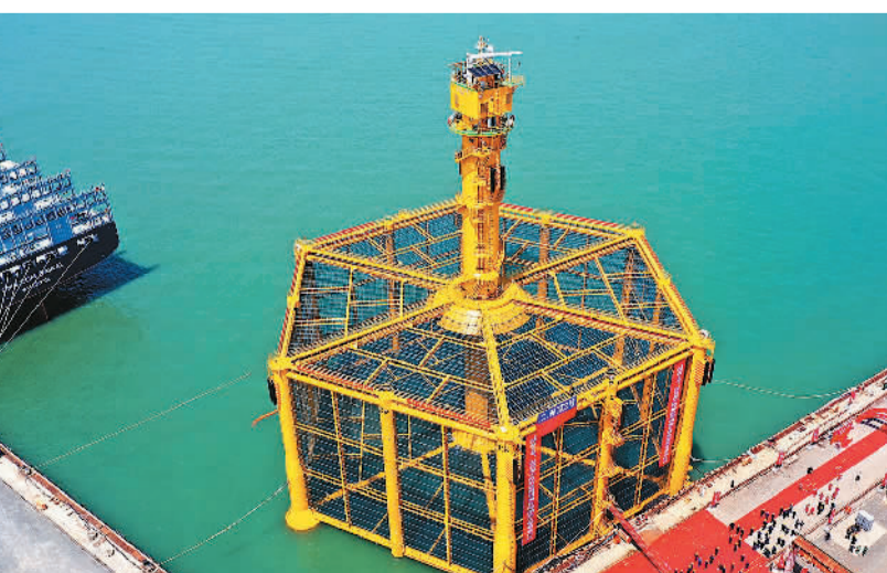
5月9日,山东青岛造船厂建造的“深蓝2号”大型智能深海养殖网箱实现陆地完工。该网箱全潜状态设计养殖水体达9万立方米,是目前中国应用海域最远、适用水深最深、养殖水体最大、功能性能最先进的深远海养殖网箱装备,搭建一体化数字化管理模式,可逐步实现深远海无人养殖。 梁孝鹏摄(新华社发)
