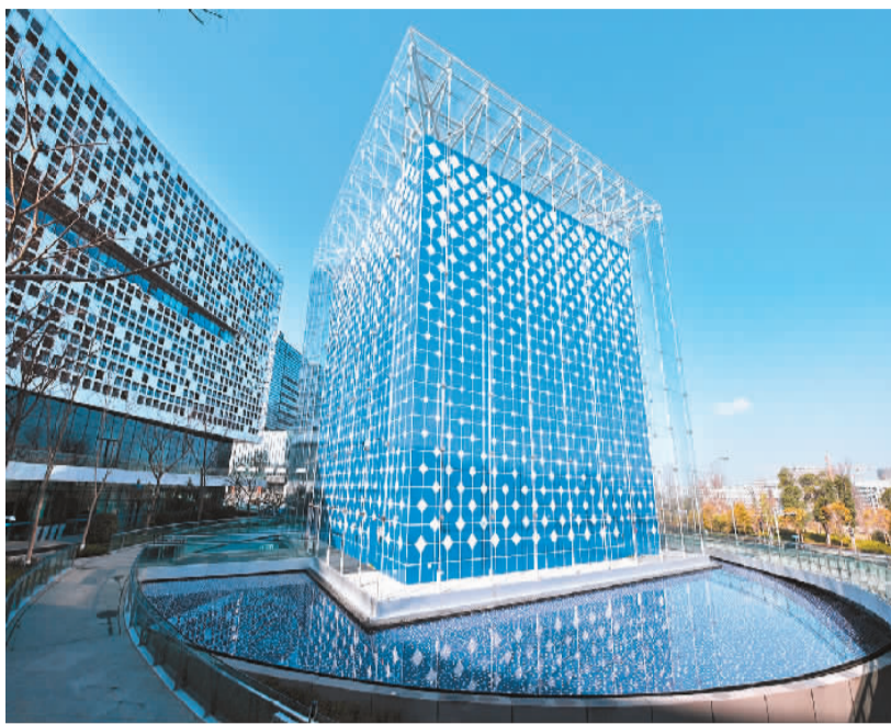
四川省成都市超算中心主机房“硅立方”。新华社记者 刘 坤 摄
