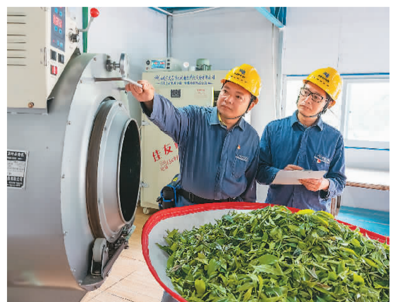
近年来，广东省广州市从化区持续提高农村地区电气化、智慧化水平，重点保障农户、农民专业合作社等用户电烘干、电加工等需求，力争到2025年建成20个新时代乡村电气化村、5个新时代电气化镇，以实际行动助力实现“双碳”目标。2023年以来，从化区已完成量化电能替代电量2891万千瓦时。图为南方电网广东广州从化供电局工作人员在检查茶机用供电情况。龚 甸摄(人民视觉)
