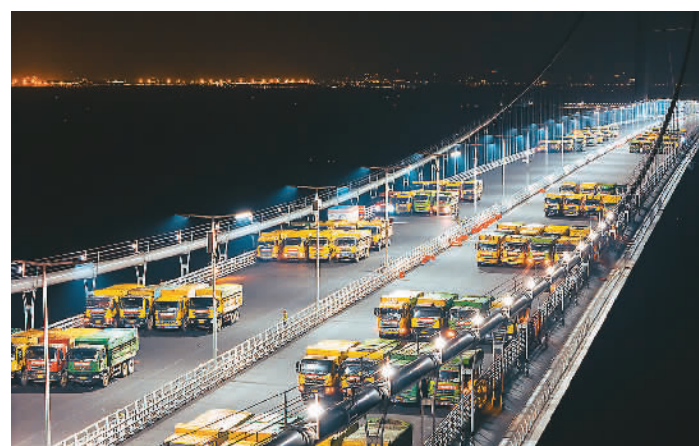
图为伶仃洋大桥进行荷载试验。
