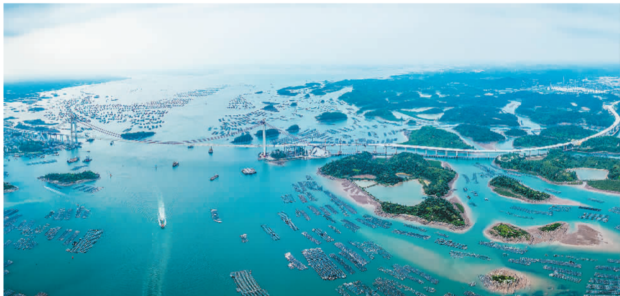
广西壮族自治区钦州市龙门大桥是广西首座千米级跨海悬索桥,项目路线全长7.637公里,其中桥梁总长6597米。大桥建成通车后,防城港与钦州港的行车时间将由原来的1.5小时缩短至25分钟左右。图为4月17日,正在建设中的龙门大桥。
