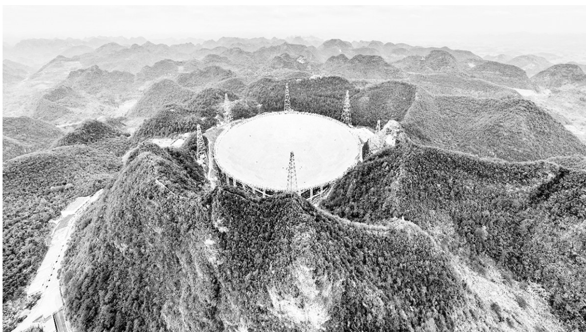
2月27日拍摄的“中国天眼”(无人机照片,维护保养期间拍摄)。
