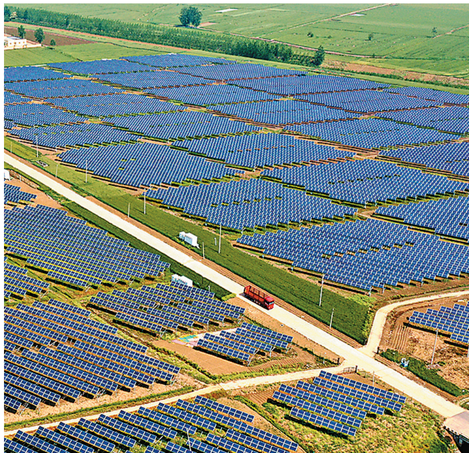
江苏省宿迁市沐阳县刘集镇清水河光伏基地里，一排排光伏发电板在阳光照耀下熠熠生辉。 张 良摄（人民图片）
