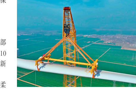
◆「巨無霸」XCA4000輪式起重機在進行風電機組的吊裝作業。 央視新聞
