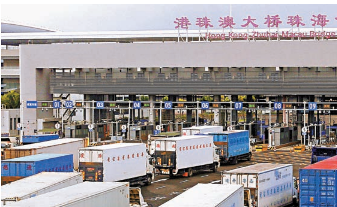
◆ 港珠澳大橋珠海口岸貨運現場。
