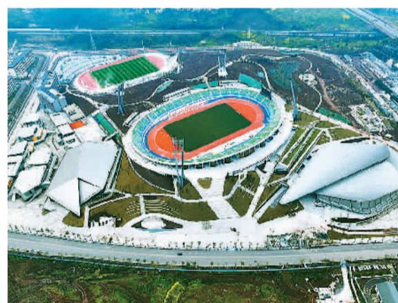
近日，重庆市第七届运动会主场馆——合川区体育中心及配套工程进入施工收尾阶段。该工程由中建八局承建，目前项目室内精装修、体育工艺、机电设备调试等施工作业已全面展开。 陈 琪摄
