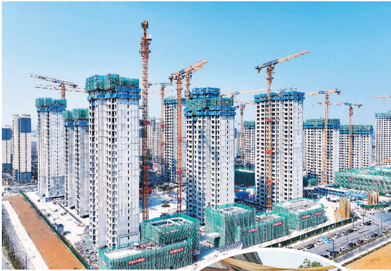
▲安徽合肥新站高新区加大城市更新力度，统筹推进“拆建安管”一体化。图为合肥新站高新区鹤翔园安置房地项目建设现场，工人们正在紧张有序施工。 张敏摄（人民视觉）
