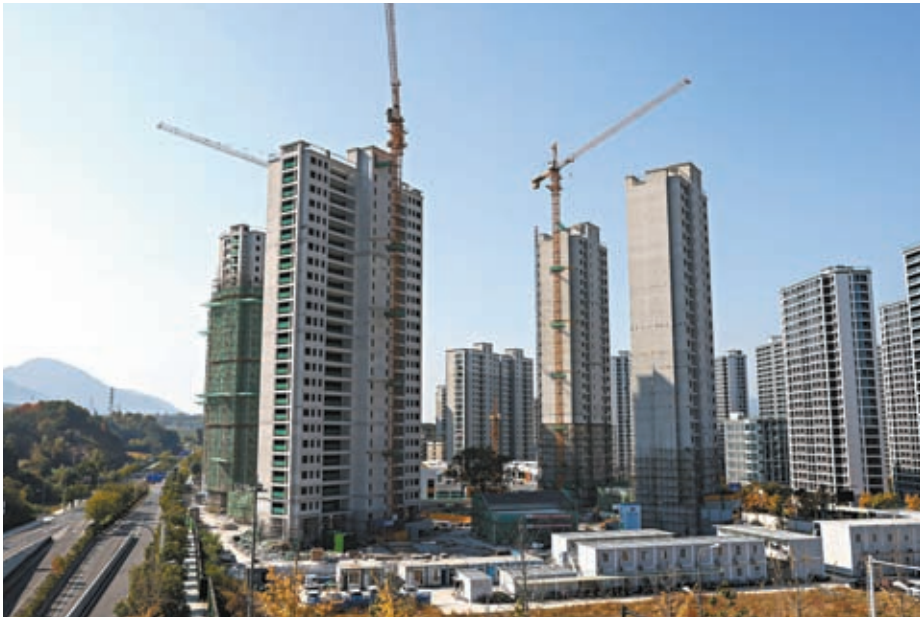
◆有分析認為，杭州樓市新政具較強示範效應，未來更多城市有望跟進實施稅收優惠政策，通過調整增值稅、個稅徵免條件減輕住房交易負擔。圖為杭州一處在建住宅。資料圖片
