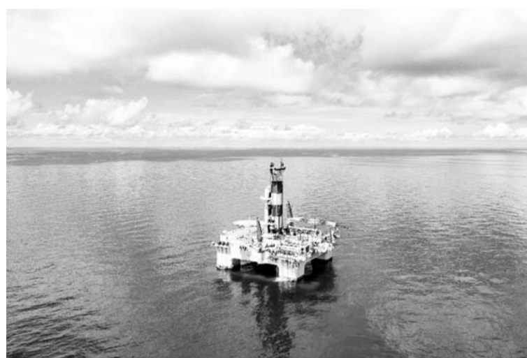
“深蓝探索”号钻井平台在开平南油田进行钻探作业(2023年11月3日摄)。
