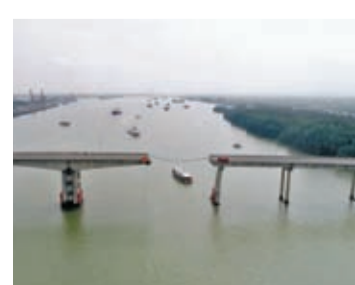
◆一艘集裝箱船22日航經瀝心沙水道時觸碰瀝心沙大橋橋墩，致瀝心沙大橋橋面斷裂。新華社
