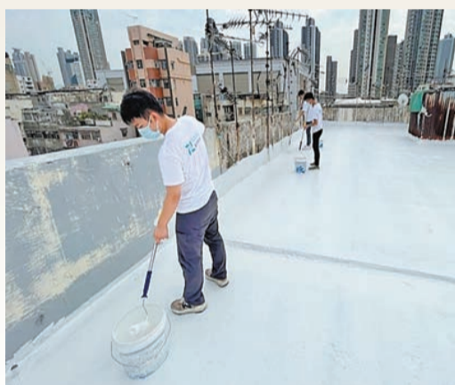
在建築物屋頂塗上「無電製冷技術」塗料，表面溫度可降30°C。
