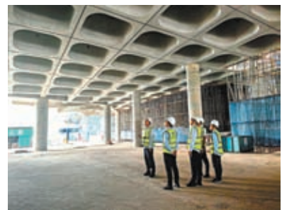
◆中建科工深圳灣文化廣場項目施工現場，工作人員正在進行安全檢查。香港文匯報記者郭若溪攝
