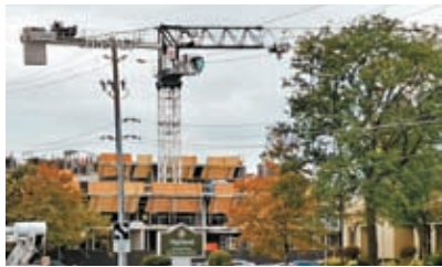
◆加國建築業蓬勃發展，政府竭力降低工地的建築安全風險。成小智攝
