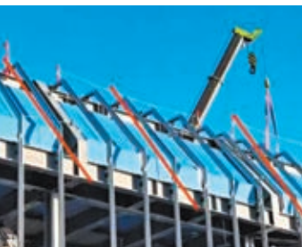
秦嶺站建築採用了裝配式、模塊化的建造體系。
