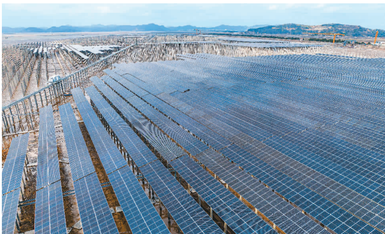
2月5日,浙江省温岭市南海涂渔光互补光伏电站项目一期工程正式并网发电,后续还将建设二期、三期工程。工程全部完工后,该光伏电站年发电量预计达7亿千瓦时。图为项目现场。徐俊杰摄(人民视觉)
