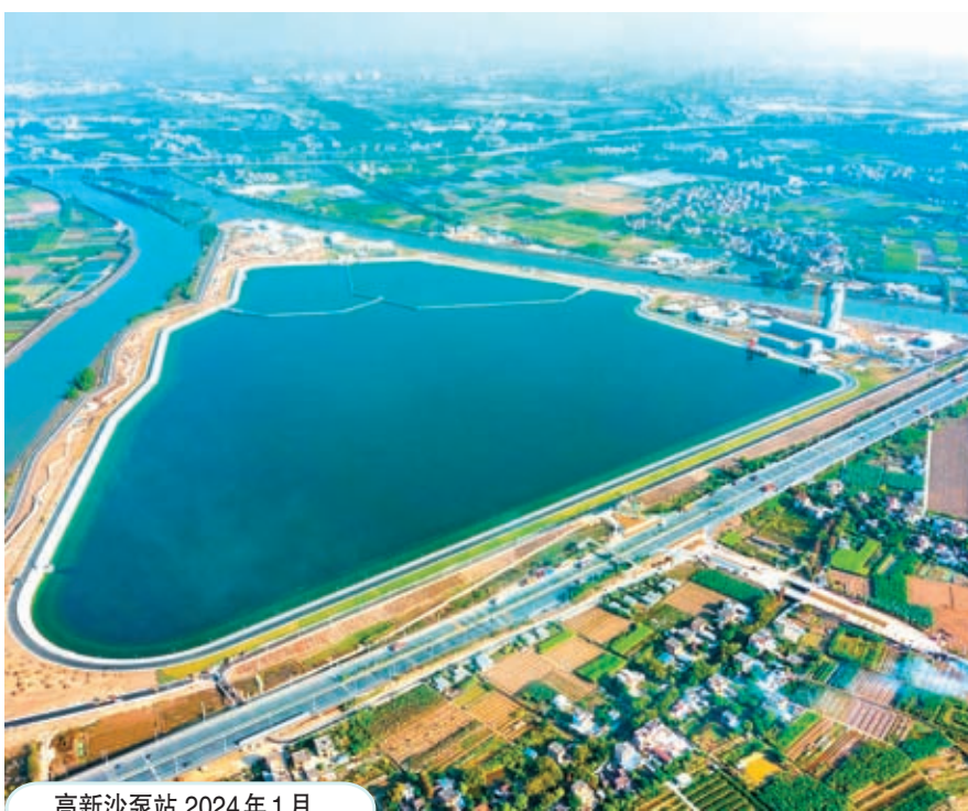
高新沙泵站 2024年1月
