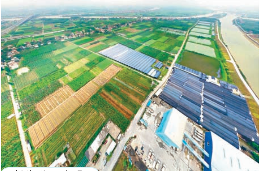
高新沙泵站 2019年8月
