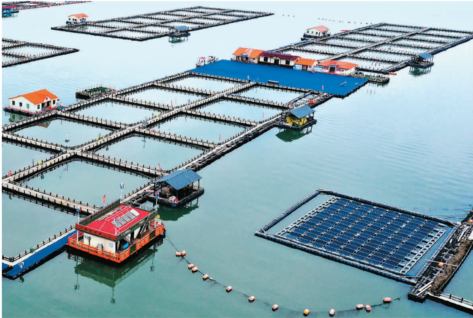
近年来,福建省宁德市开展海上养殖绿色低碳转型升级,在当地财政、税务、科技等部门的支持下,新型塑胶渔排上建起了海上“风、光、储、充、用”一体化电力试点项目,实现海上渔排不间断供电。图为宁德市三都澳白基湾海域养殖区,渔民在海上作业。王旺旺摄(人民日报)
