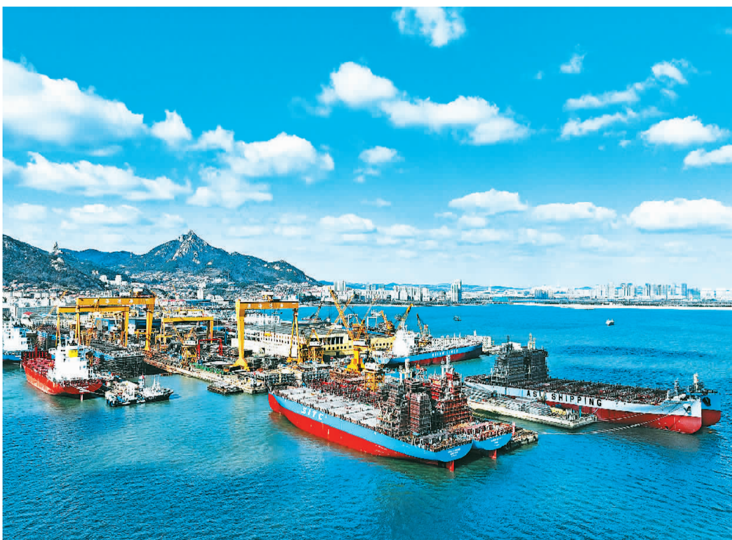
一月二十四日，在山东省荣成市石岛管理区黄海造船有限公司船坞内，各类大型船舶抓紧建造中。 王福东摄（人民视觉）
