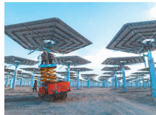
在甘肃省阿克塞哈萨克族自治县千万千瓦级可再生能源多能互补基地，工人在安装定日镜。 高宏善摄（人民视觉）
