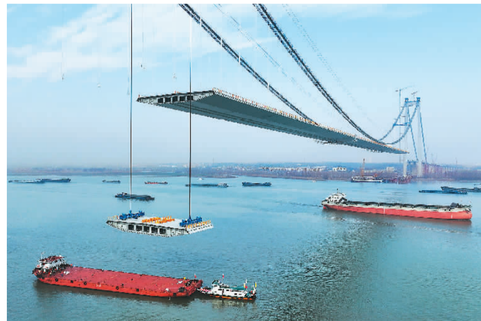
近日,位于江苏省内的龙潭长江大桥正在加紧进行钢箱梁吊装施工。龙潭长江大桥为主跨1560米的钢箱梁悬索桥,全桥共110个节段,目前已经完成57个节段钢箱梁吊装。大桥建成后,将进一步助力构建综合立体交通走廊,优化过江通道布局,完善高速公路网络。
