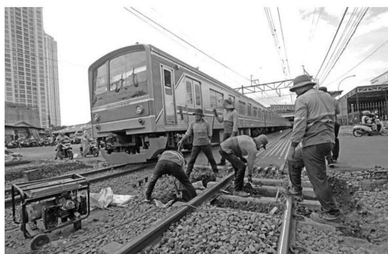
雅加达南区维修轨道 图示:铁道工作人员于1月24日在雅加达南区格巴约兰(Kebayoran)火车站,正在维修丹拿望(TanahAbang)-巴隆班让(Parung Panjang)路线的火车枕木轨道的情景,确保火车乘客的安全和舒适。
