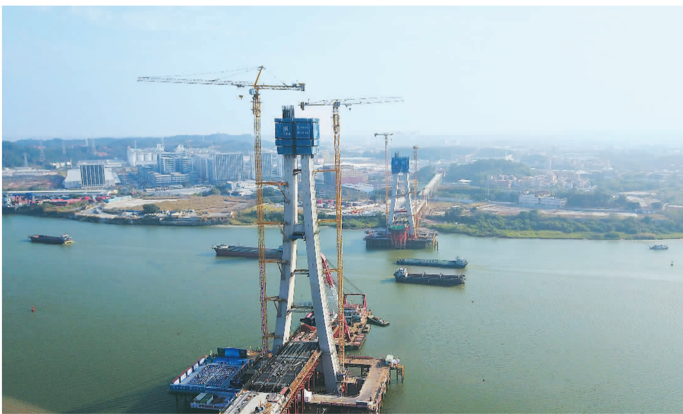
1月21日,由中铁广州工程局承建的广湛高铁佛山特大桥首片钢梁吊装顺利完成,标志着该桥钢梁架设全面展开。广湛高铁全长约400公里,起于广州火车站,途经佛山、肇庆等城市,终至湛江北站,设计时速350公里,通车后将进一步完善粤港澳大湾区轨道交通体系。新华社记者 田建川摄
