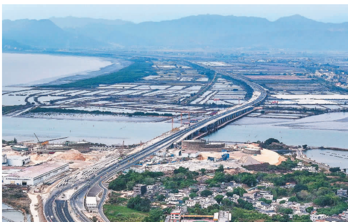
近日,由中铁四局承建的深汕西高速改扩建项目长沙湾跨海特大桥左幅主跨合龙。该桥全长2108米,采用新建右幅新桥、再拆除既有特大桥重建左幅的施工方式。图为大桥跨越广东省汕尾市海丰县长沙湾入海口。
