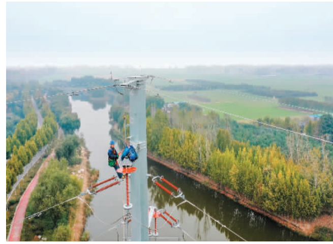
工人正在安装新型复合防鸟装置。
