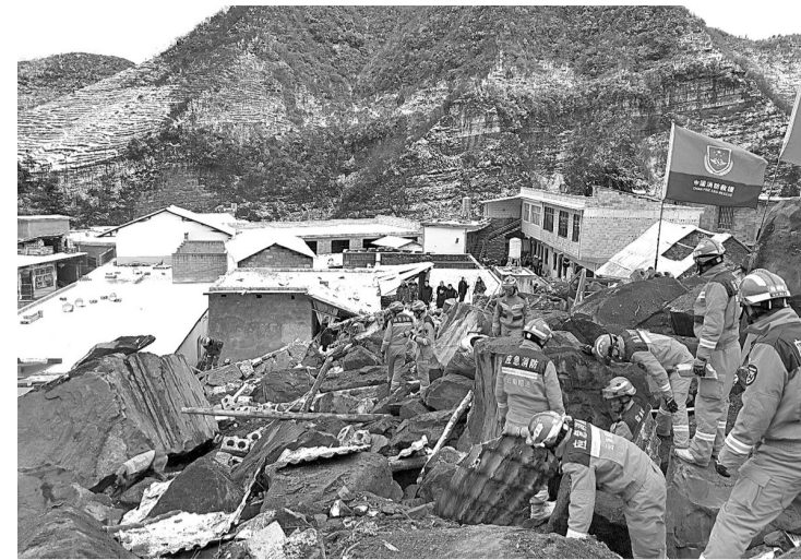
1月22日在云南省昭通市镇雄县塘房镇凉水村拍摄的救援现场。
