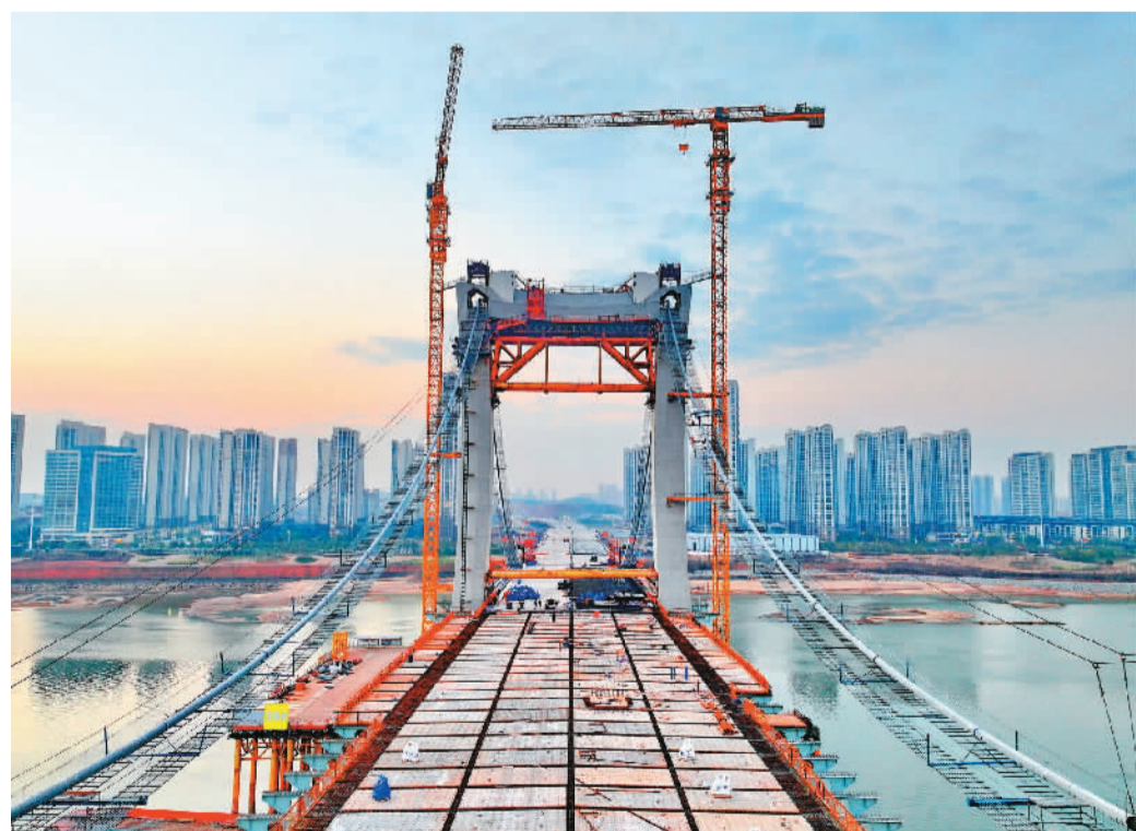
近日，由江西省南昌市政公用集团建设、中铁大桥局承建的洪州大桥过江主塔结构贯通。该桥采用“昌”字形双塔，为全国最大跨径比钢混组合梁自锚式悬索桥。图为洪州大桥施工现场。朱海鹏摄（人民视觉）
