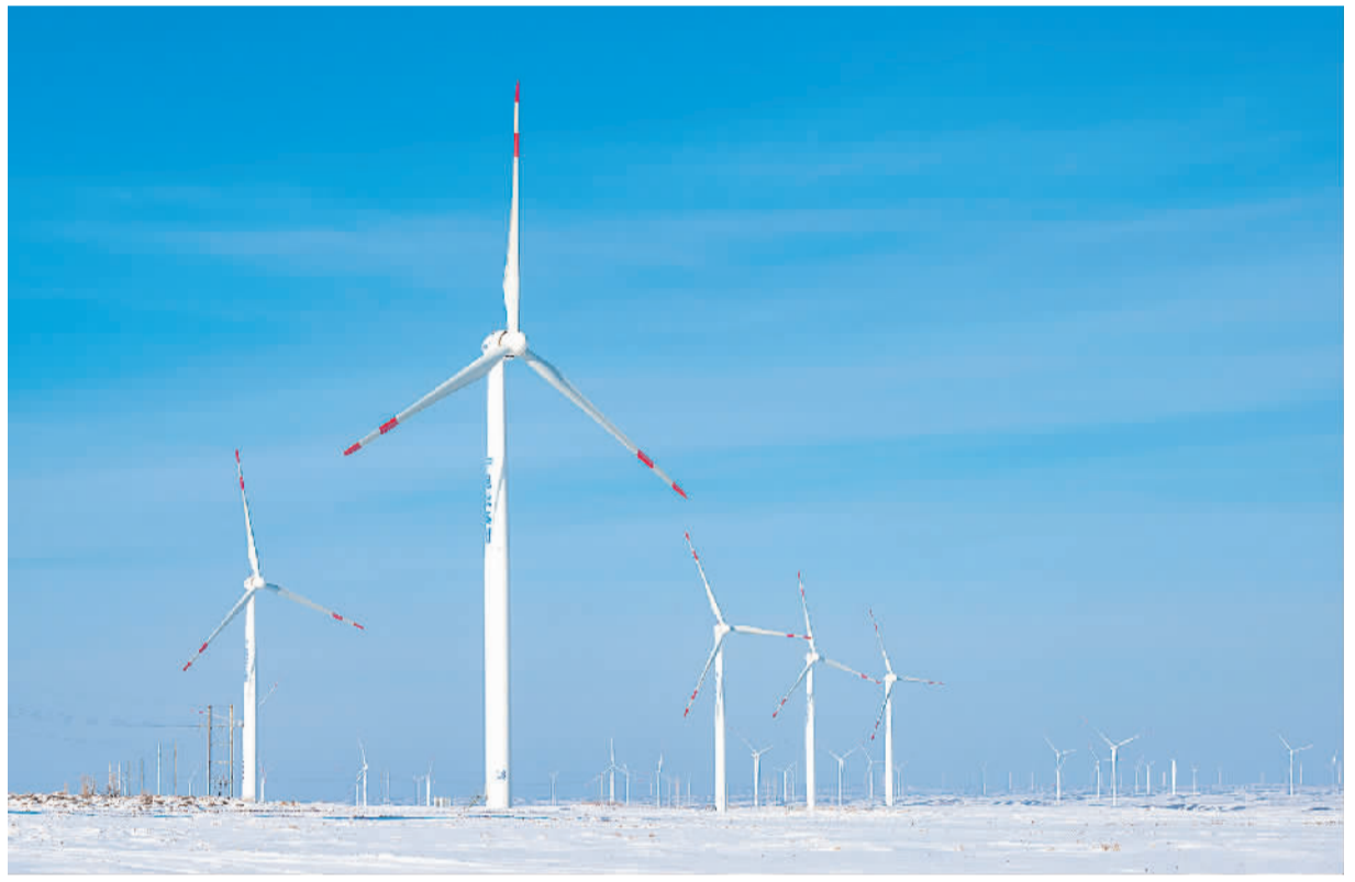
新疆维吾尔自治区昌吉回族自治州木垒哈萨克族自治县立足丰富的风能和太阳能资源，着力打造千万千瓦级清洁能源基地。图为木垒哈萨克族自治县老君庙风电场。何龙摄（人民视觉）
