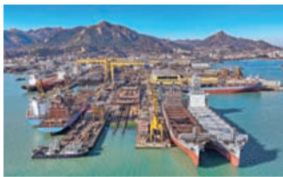
在山東一個船塢內，工人抓緊建造各類大型船舶。
