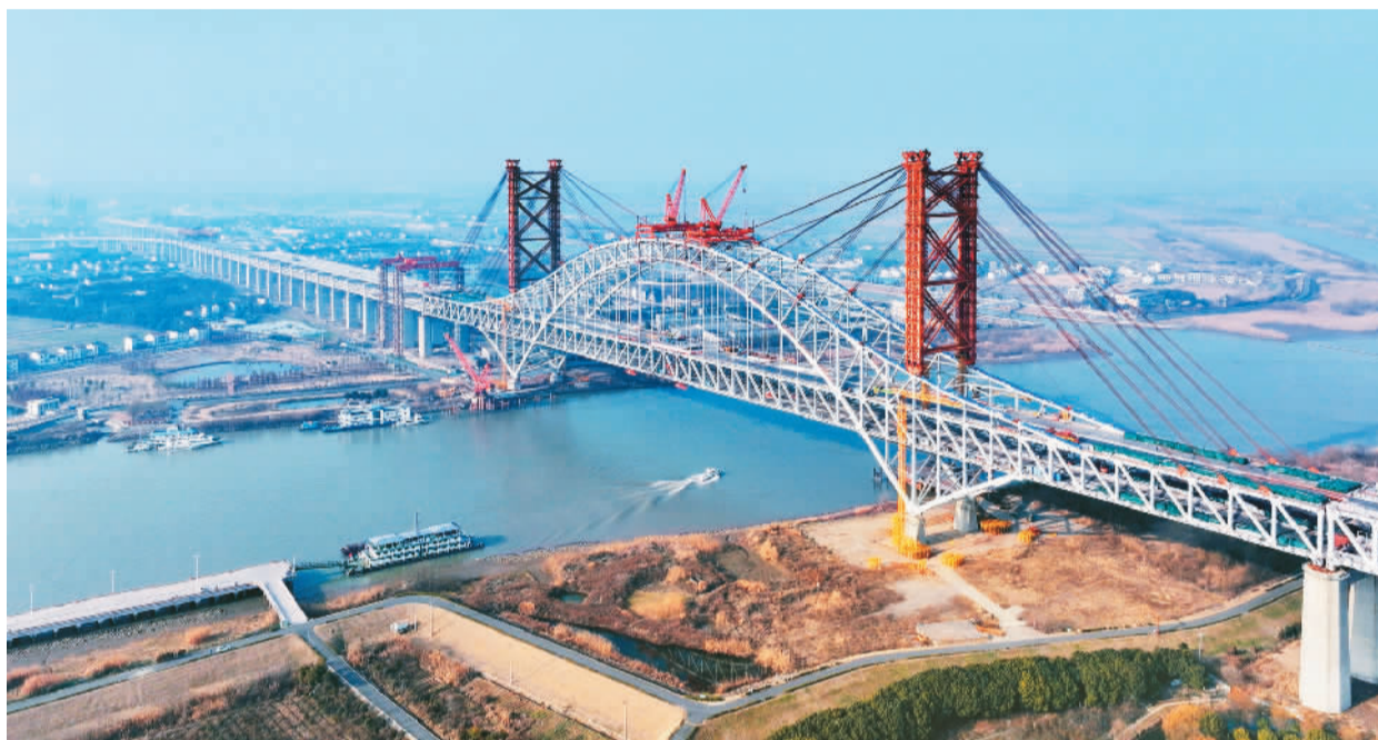
1月12日，连接江苏常州与泰州的常泰长江大桥工程取得突破性进展，位于常州侧的录安洲专用航道桥顺利合龙。录安洲专用航道桥是世界最大跨度公铁两用钢桁拱桥，主跨388米。
