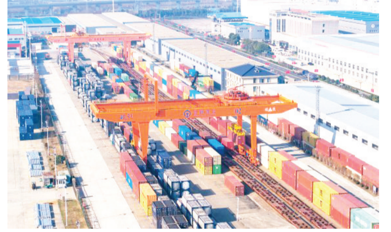
2023年12月25日，在中国铁路上海局集团有限公司海安物流基地，集装箱门吊进行集装箱装运作业。新华社发(翟慧勇摄)
