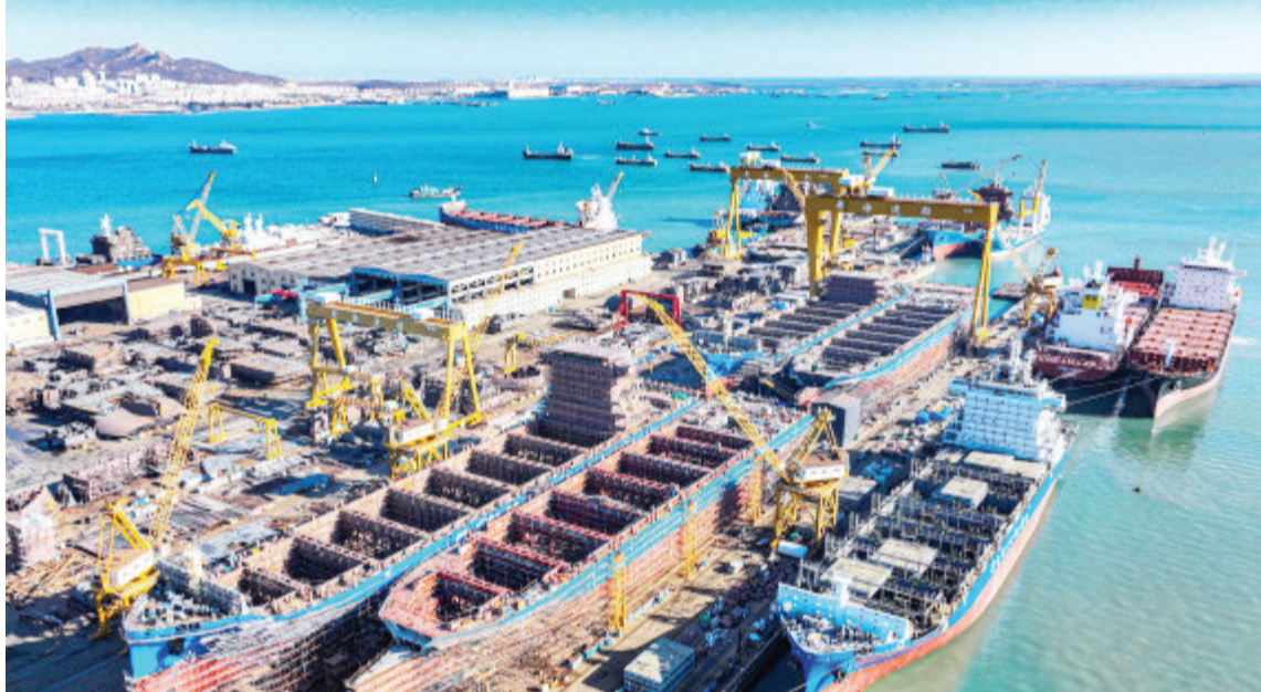
1月10日，在山东省荣成市石岛管理区黄海造船有限公司船坞内，工人抓紧建造各类大型船舶(无人机照片)。目前，该企业手持各类高附加值船舶订单超过70艘，所有船台持续保持满负荷生产状态，出口占比已接近总产量七成。新华社发，李信君摄
