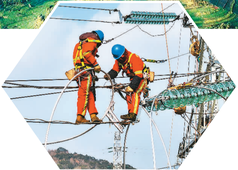
▲ 1月3日，在浙江舟山北塘110千伏输电工程11号铁塔上，国网舟山供电公司电力施工人员正在进行导线压接作业，以确保当地电力供应。
