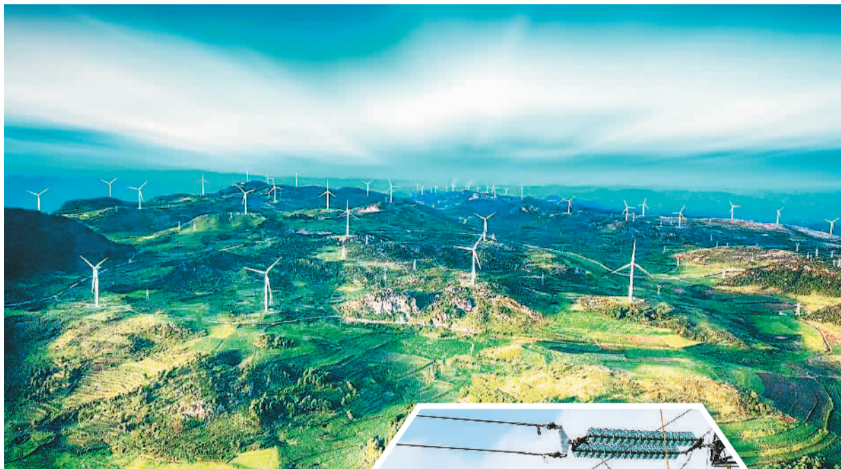
▲ 中国大唐集团有限公司云南文山锦屏山风电项目172台风机机组近日全部并网发电。该项目平均海拔2210米，装机容量86万千瓦，预计每年可输送20亿千瓦时清洁电能。至此，总装机容量110.3万千瓦的云南首个高原山地百万千瓦级风电基地建成投产，为当地电力供应提供保障。图为云南文山锦屏山风电项目一瞥。
