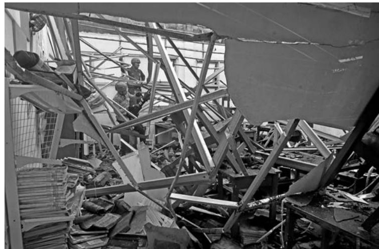
茂物市警察一号国立小学教室屋顶倒塌 1月3日,由于西爪哇省茂物市降暴风雨缘故,结果警察一号国立小学教室屋顶倒塌,幸好没有造成人命伤亡。
