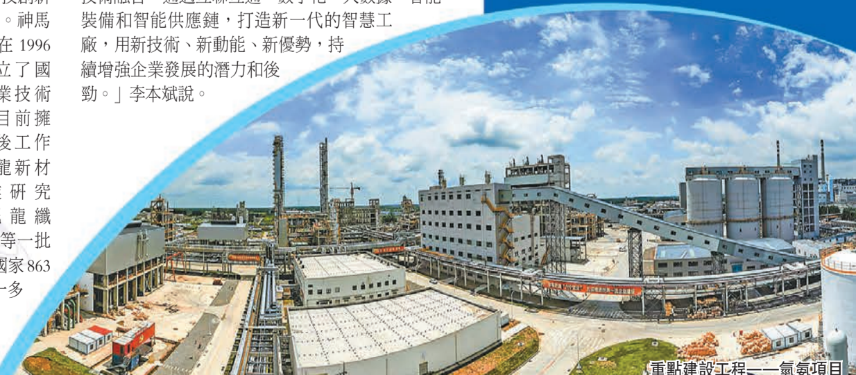
重點建設工程——氫氣項目
