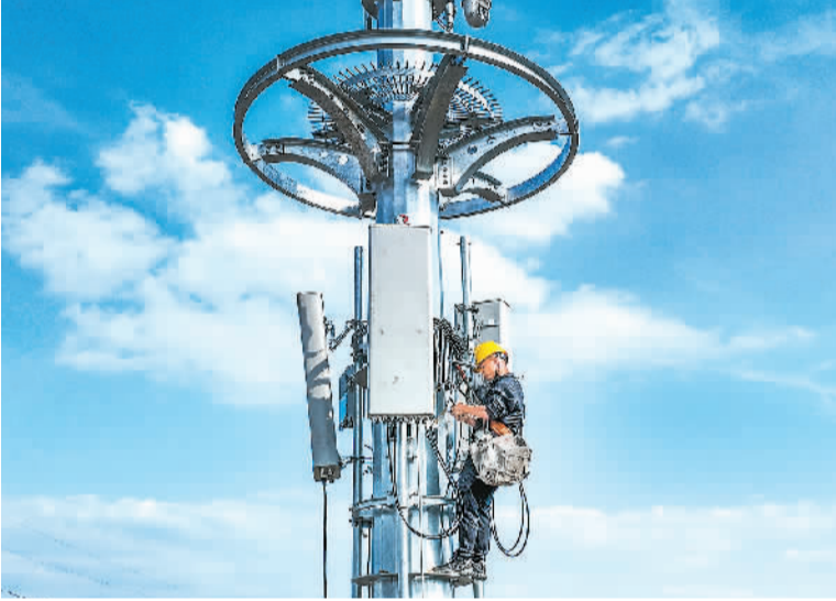
工作人员在浙江省台州市仙居县现代工业园区铁塔上安装5G设备。 陈月明摄(人民视觉)
